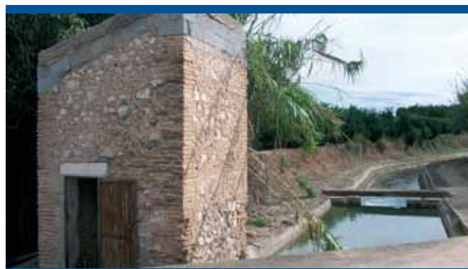
2ª Caseta de desaiçüe de la Séquia de Carcaixent (Sumacàrcer)
