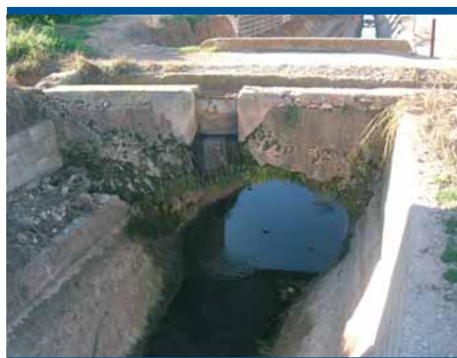
Aqüeducte del Braçal d'Estellador (Castelló de la Ribera)
