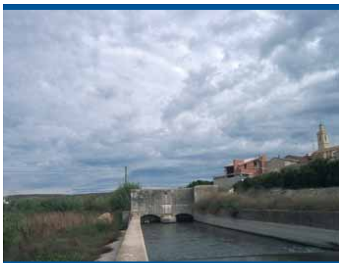
Caseta de salida de la Séquia Comuna d'Ènova (Xàtiva)
