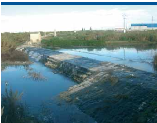
Presa de realimentació d'Escalona (Castelló de la Ribera)
