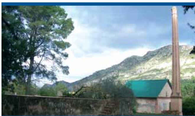
Vapor i Bassa de la Casa Vella (Alzira)
