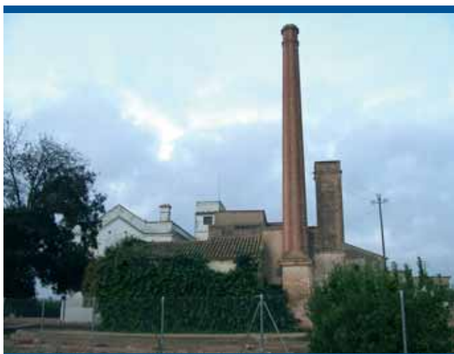
Vapor de Vèrnia (Benifaió)
