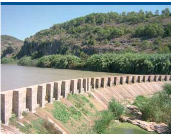
Assut de Llombai (Llombai-Real de Montroi)
