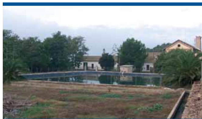
Motor i Bassa del Prefaci (Benifaió)
